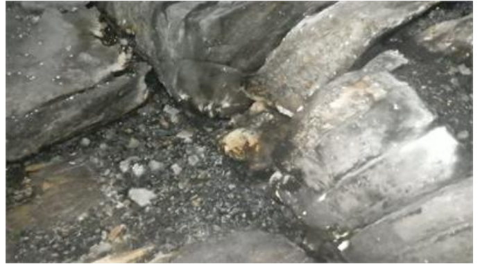
Mikrobiell påväxt på marken i krypgrunden
