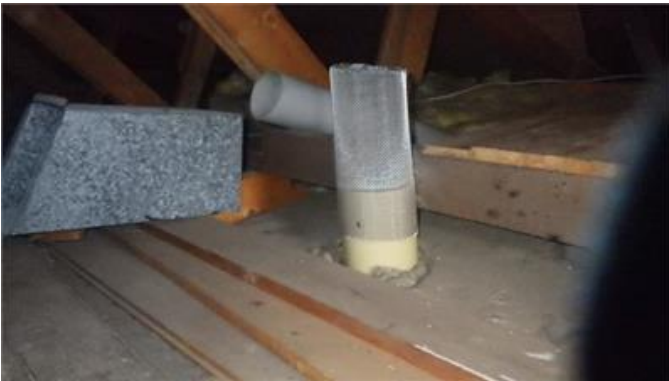
Rör som avslutas på vinden
