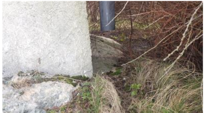
Stuprör avslutas ovan mark
